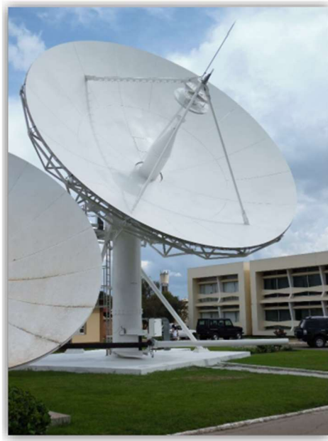
Figure 2.03 : Antenne VSAT, HUB d'Ivato (11 mètres)
