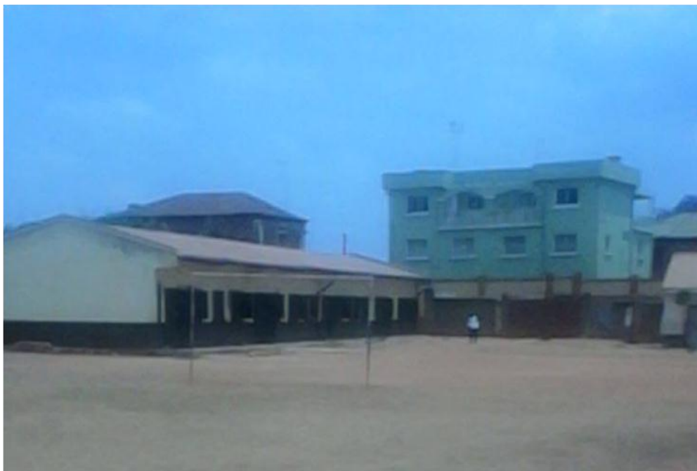
Figure 3 : Nouveau bâtiment du CEG
