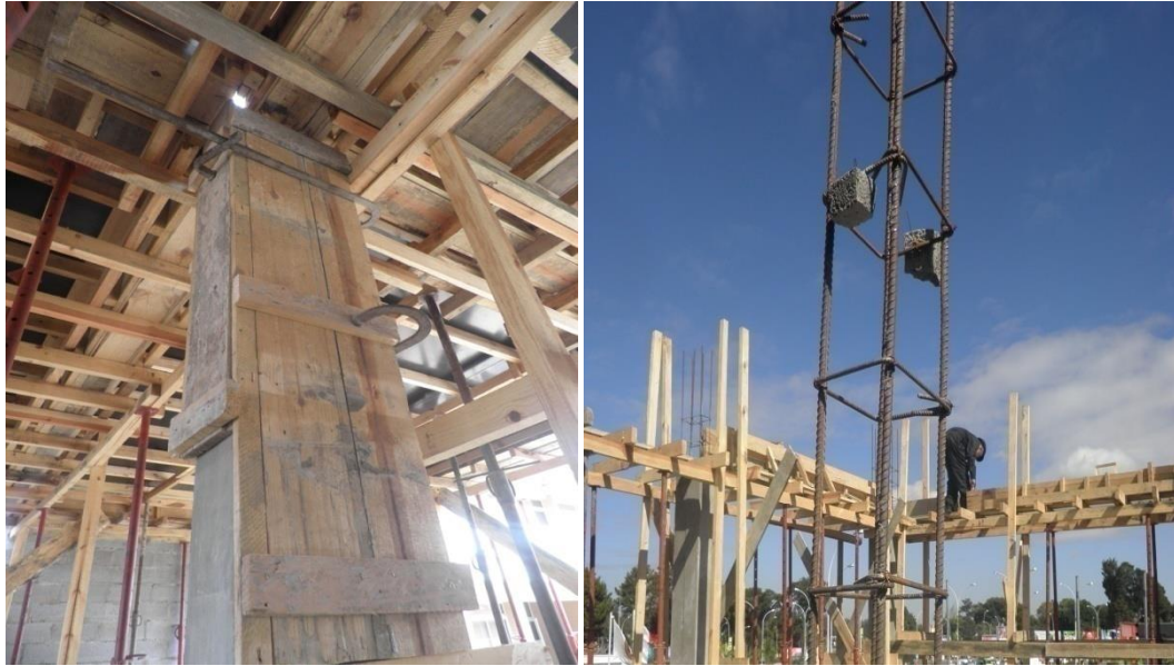
Coffrage entre poteau et dalle Coffrage de la poutre
