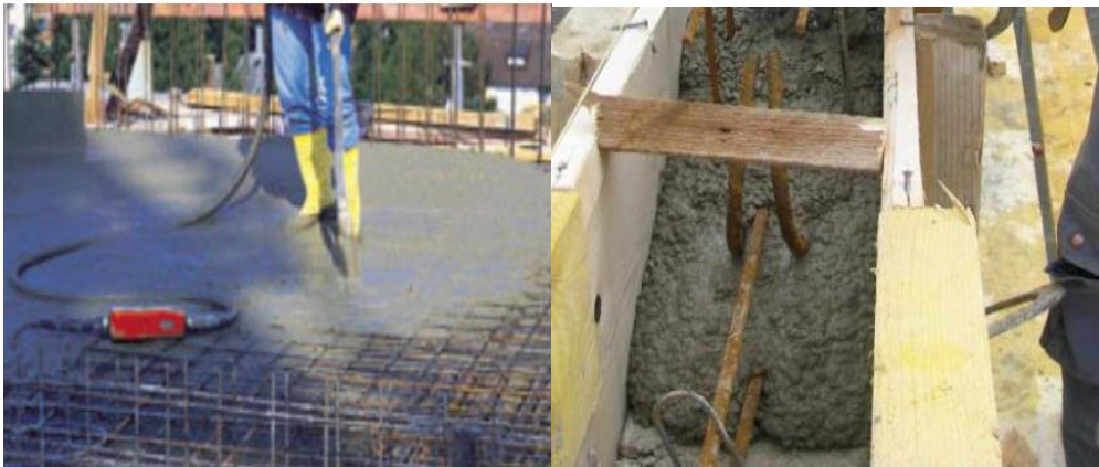
Vibration du béton de la dalle
