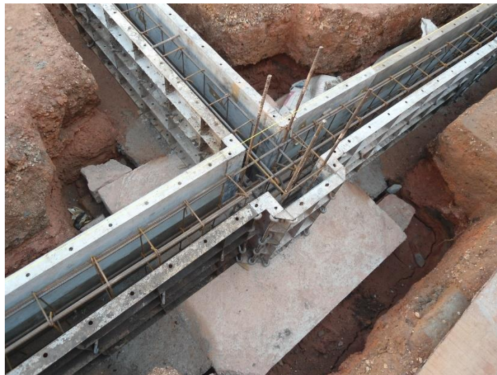
Figure 29 : Coffrage Métallique
