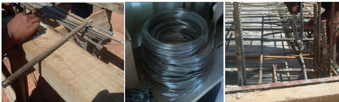
Façonnage de l'armature
