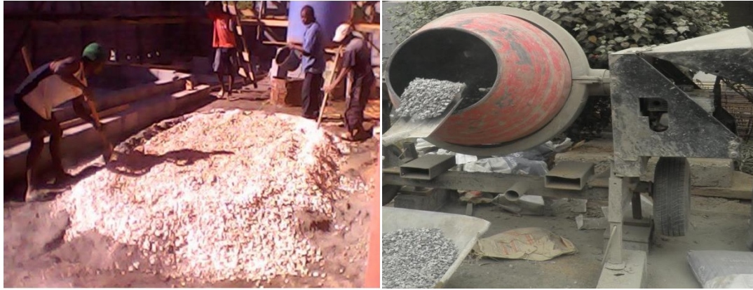
Bétonnage manuelle
