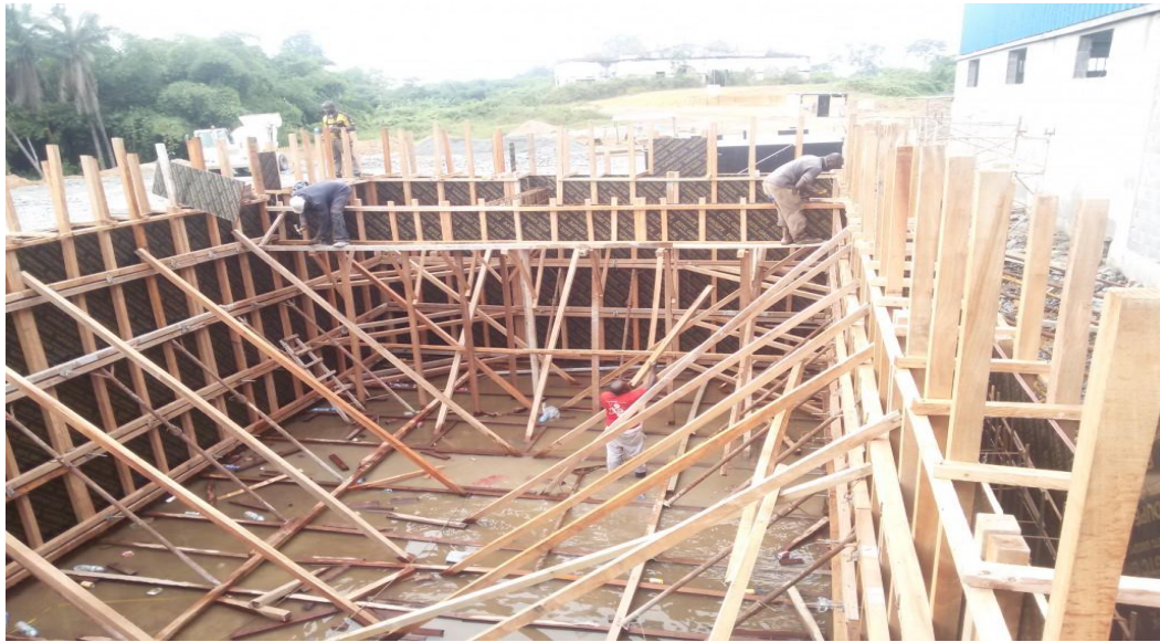
Photo 2 : Construction du voile
