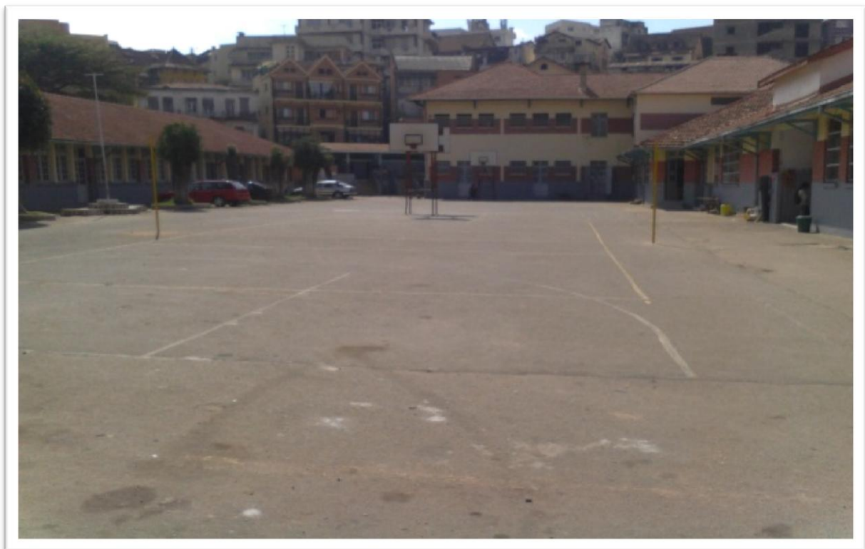
Photo n° 2: Vue partielle des bâtiments du lycée
