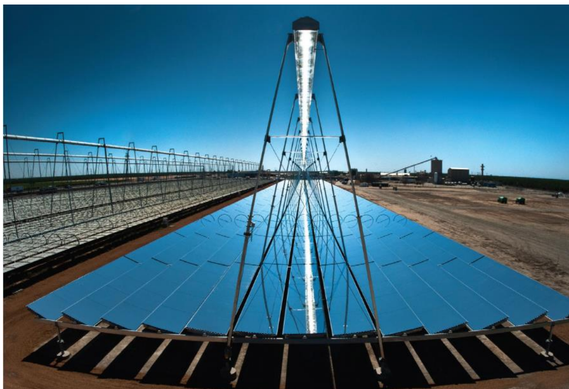
Figure 1.9 : Schéma d'une centrale à réflecteur linéaire de Fresnel
