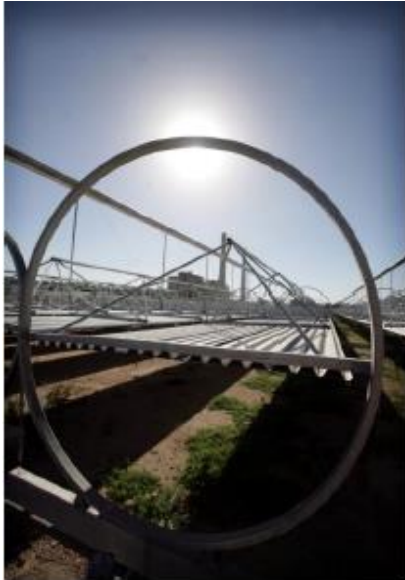
Figure 1.10 : Système de tracking : design circulaire d'Austra (à gauche) et appuis asymétrique de Solarmundo (à droite)
