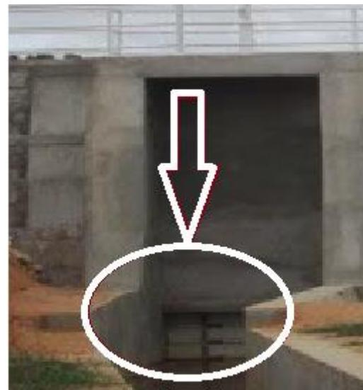
Figure 26: Canal dissipateur
