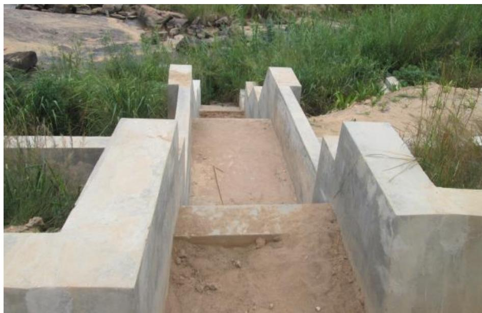
Figure 55: Photo du radier du pont canal
