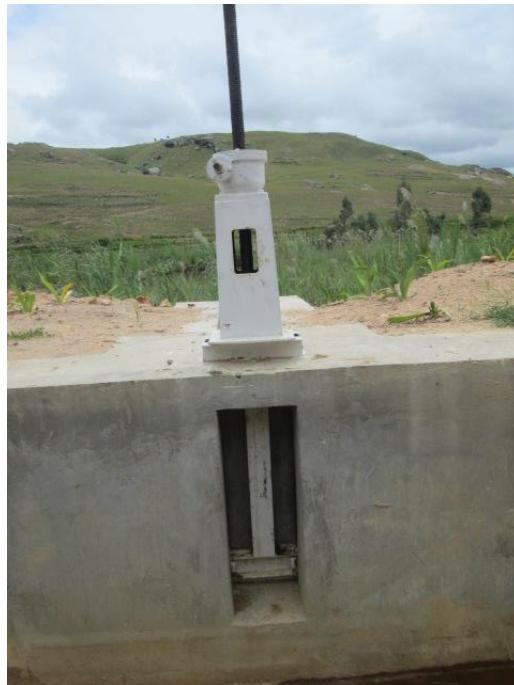
Figure 29: Prise d'irrigation
