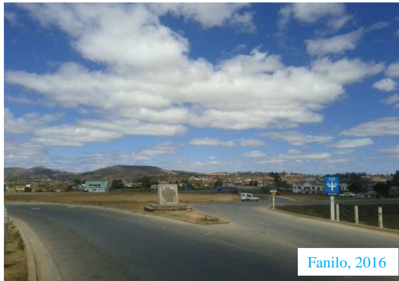
Giratoire de Mandikanamana fin du tronçon PK 10 + 00
