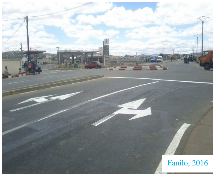
Construction d'un nouveau giratoire au PK 7 + 400
