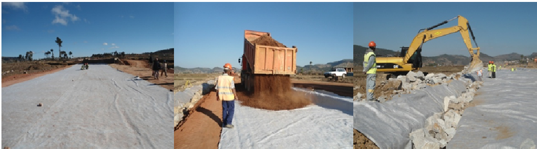
Figure 44 : Photo de l'installation, recouvrement du géotextile et de la réalisation de l'ancrage
