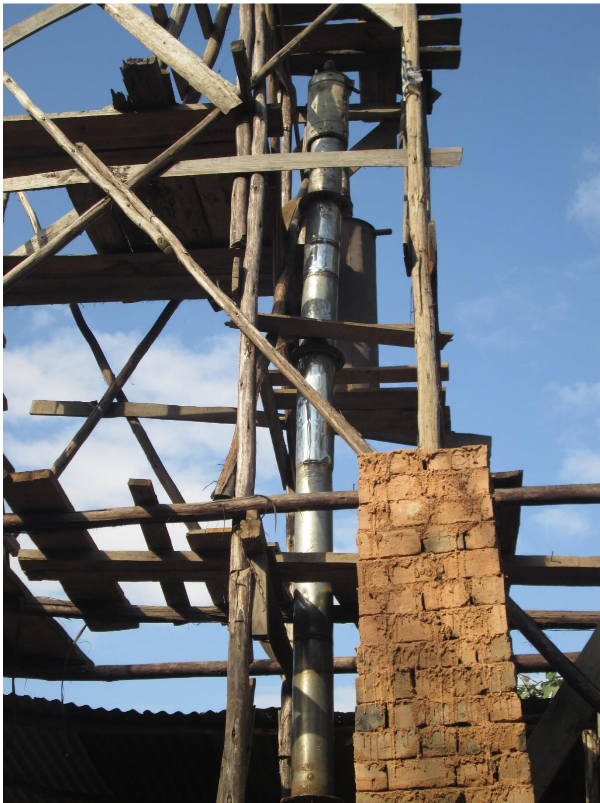
Photo 3: la colonne de rectification avec l'échafaudage nécessaire pour son assemblage
