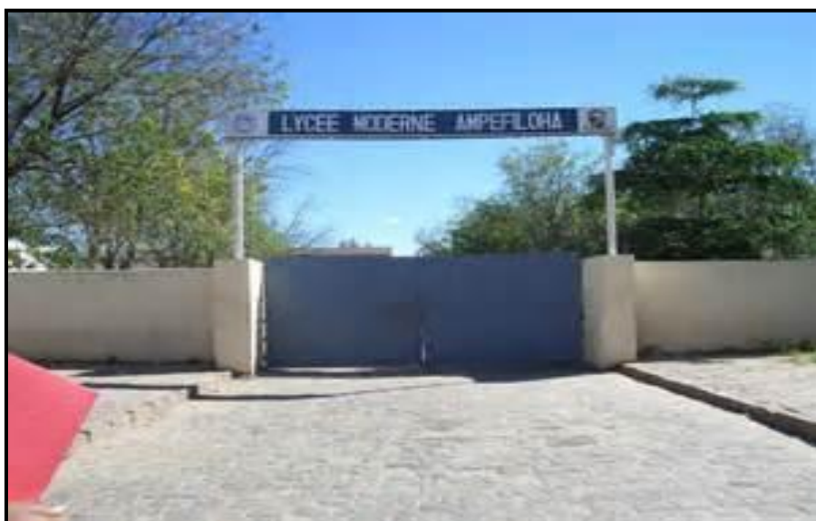
Photo n°01 : Le portail principal du L.M.A. (vu de l'extérieur)
