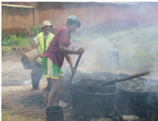
PHOTOS 73- Préparation couche de revêtement
