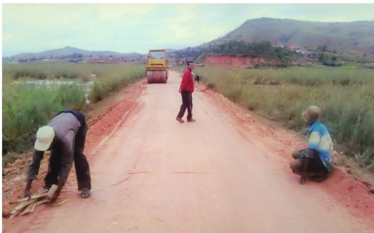
PHOTOS 60- Compactage du remblai
