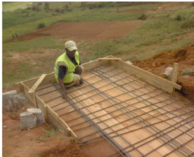
PHOTOS 64- Coffrage et ferrailage
