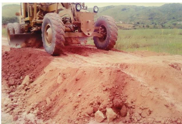
PHOTOS 59- Répartition et malaxage
