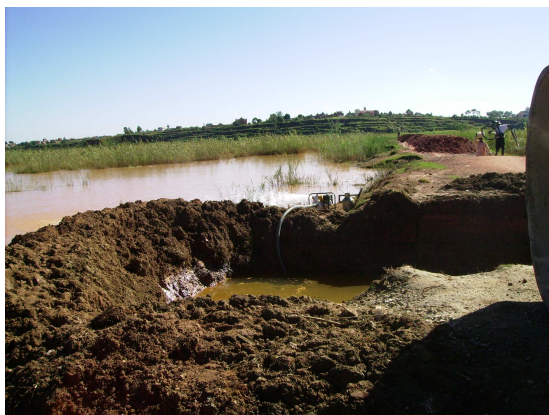
PHOTOS 62- Mise à sec de la fouille
