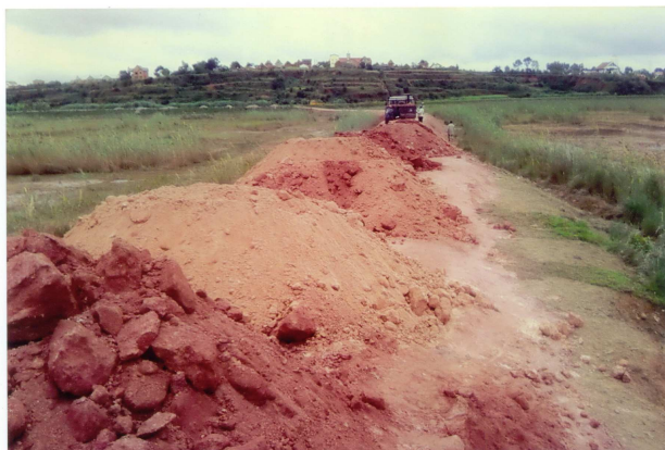
PHOTOS 58- Mise en tas de remblais
