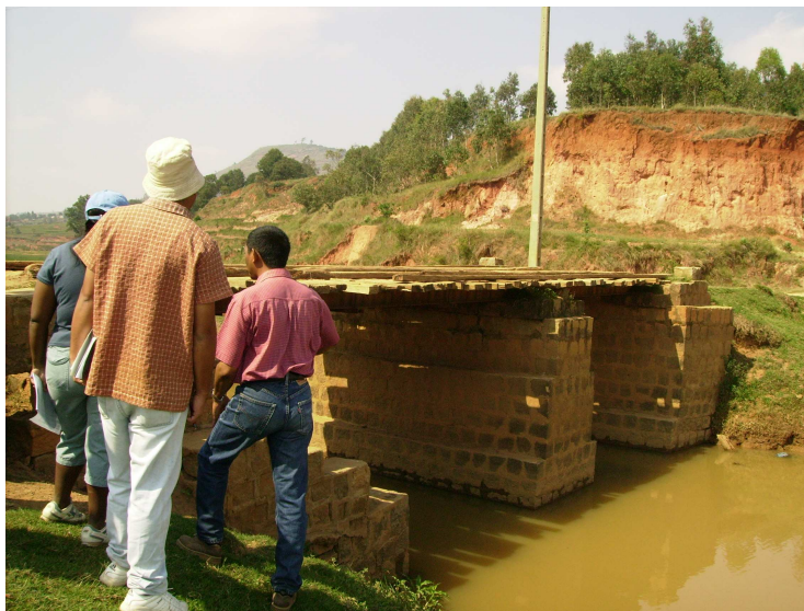
PHOTOS 54- Pont en bois PK 1+600
