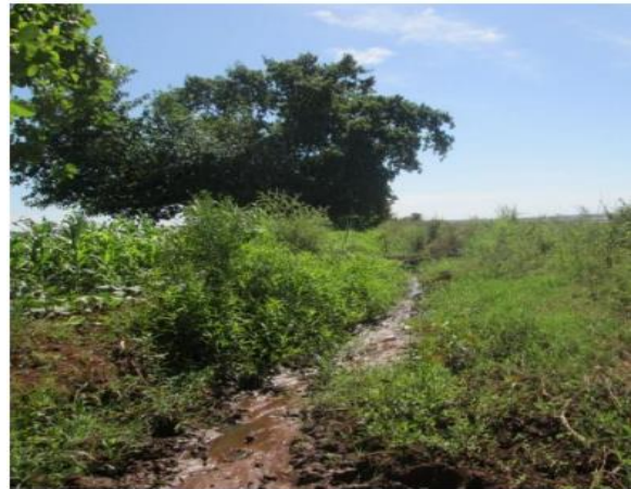
Image 15 Drain Principal Betay : ensablé et bouché par des végétations avant sa réhabilitation
