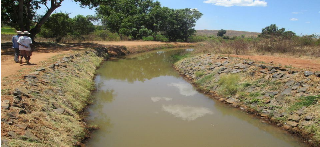
Image 21 Protection des berges des canaux (empierrement et engazonnement)
