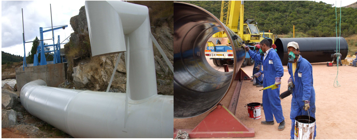
Figure 3.13 : Conduite forcée et cheminée d'équilibre - préparation de la pipe
