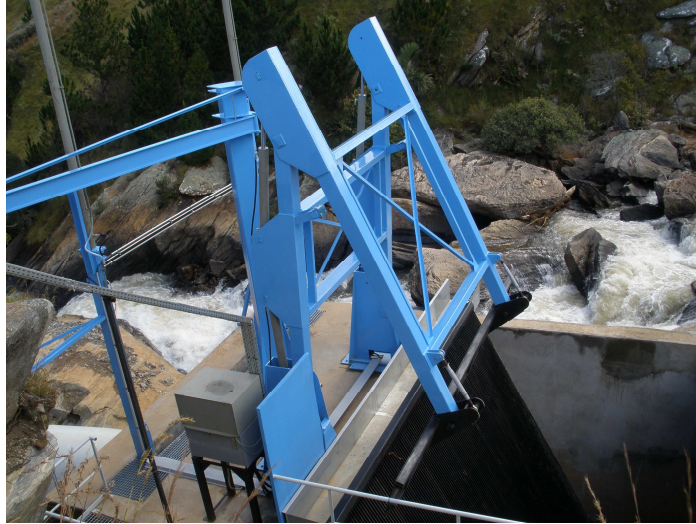
Figure 3.11 : Dégrilleur et vanne (bleu)
