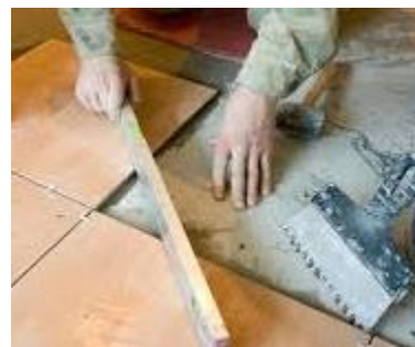
Vérification de sa planéité
