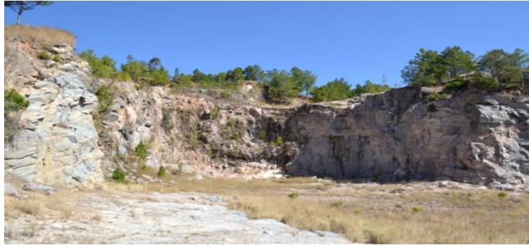
Figure 32 : Vue générale de la carrière d'Ambatomarina
