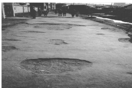
**Photo 2 : Dégradation généralisée B1**
