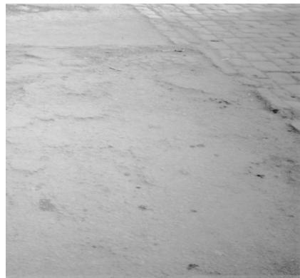
**Photo 3 : Dégradation généralisé du trottoir**
