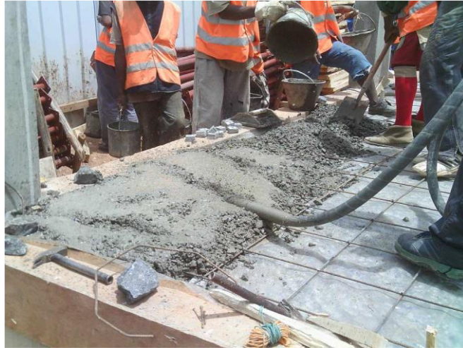
Photo 16 : Epannage et vibration du béton de la dalle
