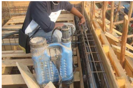
Photo 4 : Enduire du liquide d'accrochage
