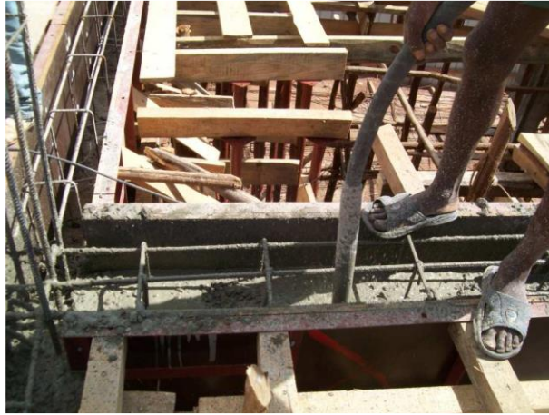
Photo 13 : Vibration du béton
