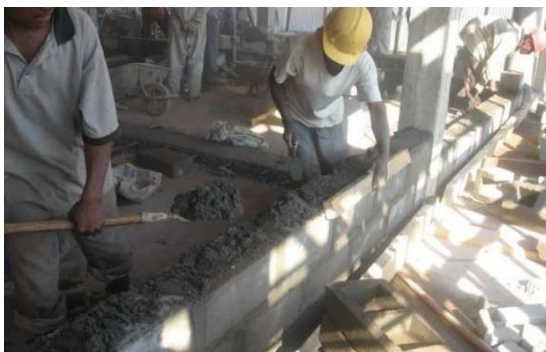
Photo 20 : Mise en œuvre de la maçonnerie de parpaings
