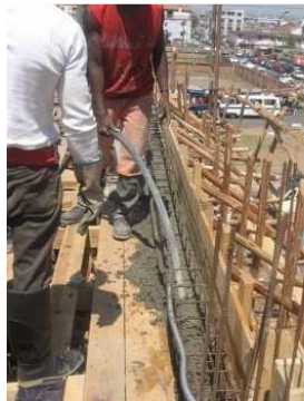
Photo 5 : Vibration du béton
