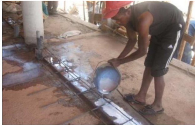
Photo 19 : Imprégnation avec le liquide d'accrochage de la surface concernée
