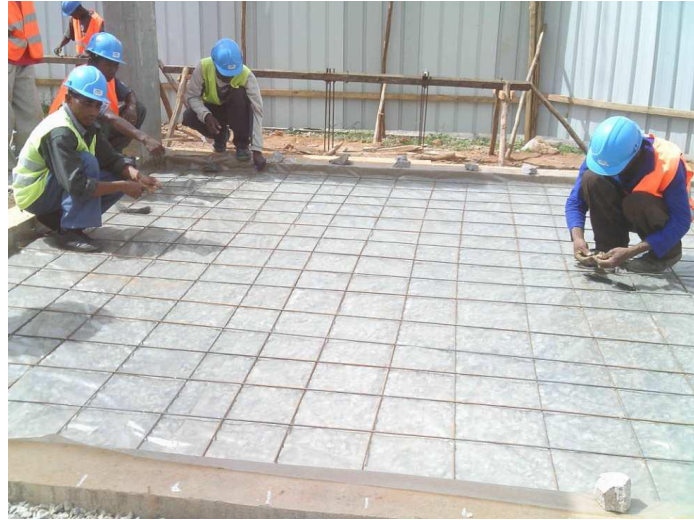
Photo 15 : Ferraillage de la dalle
