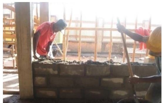
Photo 20 : Mise en œuvre de la maçonnerie de parpaings
