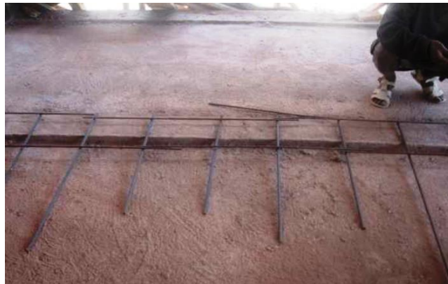
Photo 18 : Mise en place des armatures aux pieds des murs
