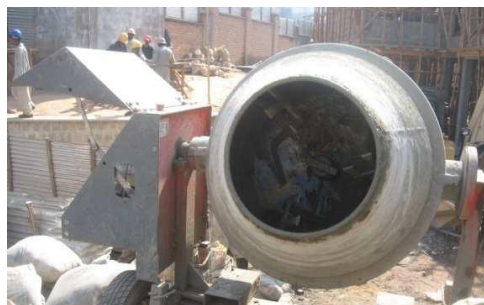
Photo 3 : Malaxage à la bétonnière
