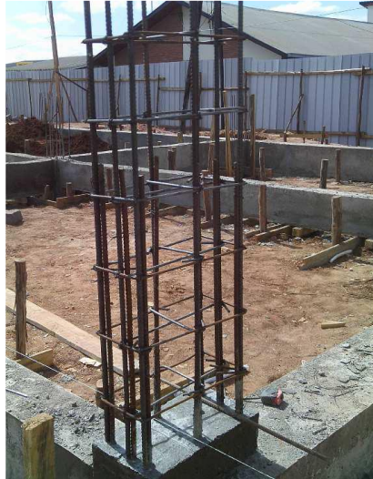
Photo 8 : Ferrailage du poteau
