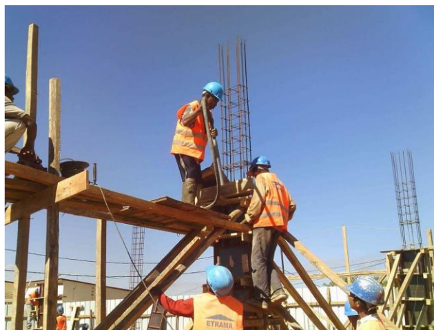
Photo 11 : Vibration du béton
