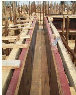
Photo 12 : Coffrage des poutres
