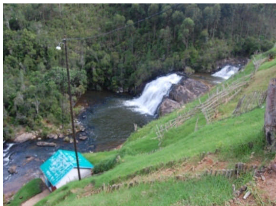
Fig.1-2 Centrale pico hydroélectrique à Ambaravarana, [Source : Fondation Tany Meva]
