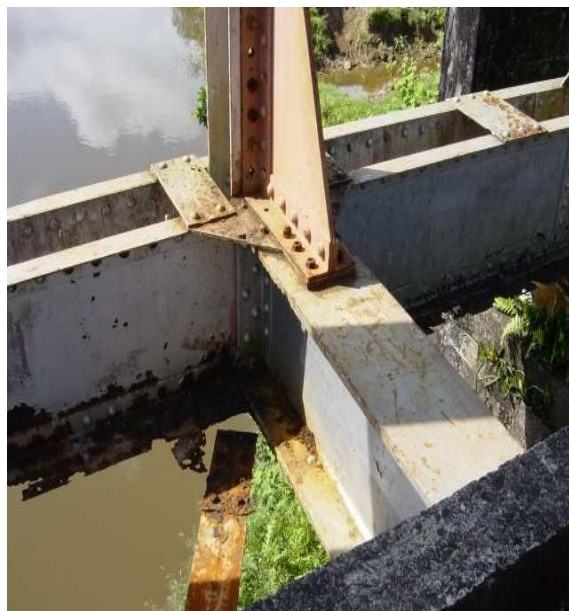
Photo 5 : Corrosion au niveau de la membrure inférieure
