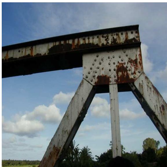
Photo 4 : Corrosion au niveau de la membrure supérieure
