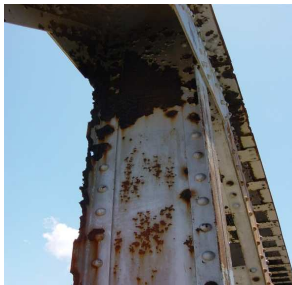
Photo 4 : Corrosion au niveau de la membrure supérieure
