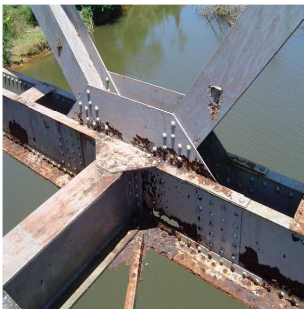
Photo 5 : Corrosion au niveau de la membrure inférieure
