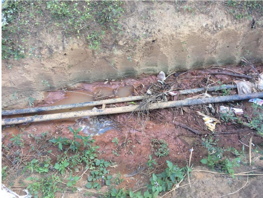
Photo 5 : Etat actuelle des conduites
