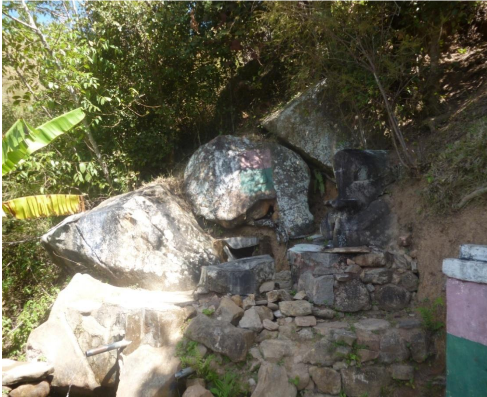
Figure 20 : La source aménagée de Ramaroanaka dans une roche granitique fracturée
