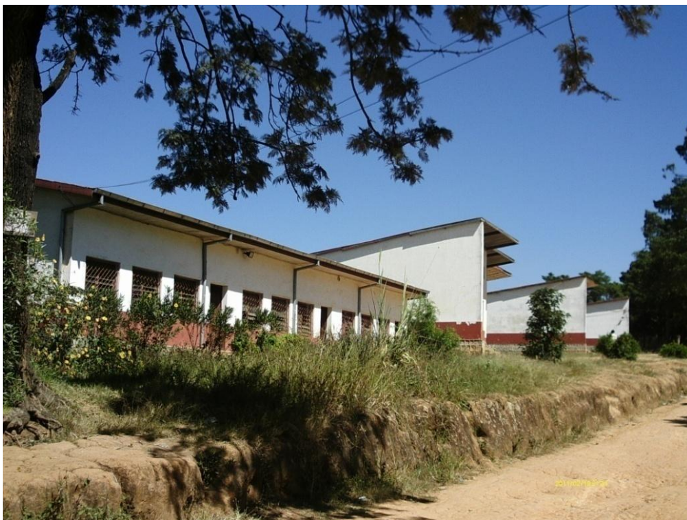
Figure 10 : Les bâtiments du lycée privé Adventiste Rajoelison Soamanandrarin (source : Auteur)
