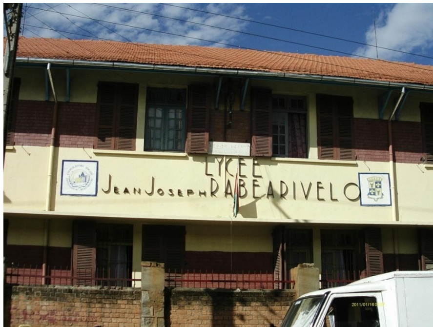
Figure 6 : Lycée Jean Joseph Rabearivelo (source : Auteur)
