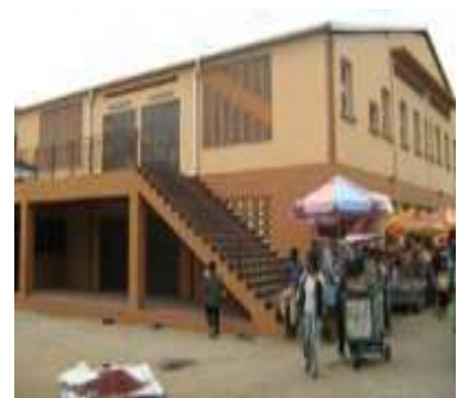
Figure 3: le seul marché en norme opérationnel
