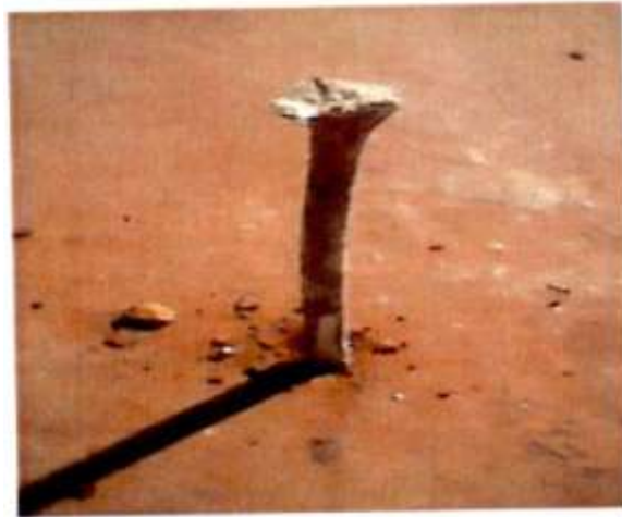
Figure 17: Réimplantation de piquet d'axe
